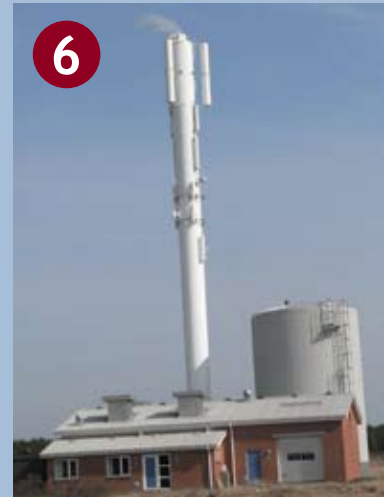
6 KLITMØLLER CHP plant (natural gas)
